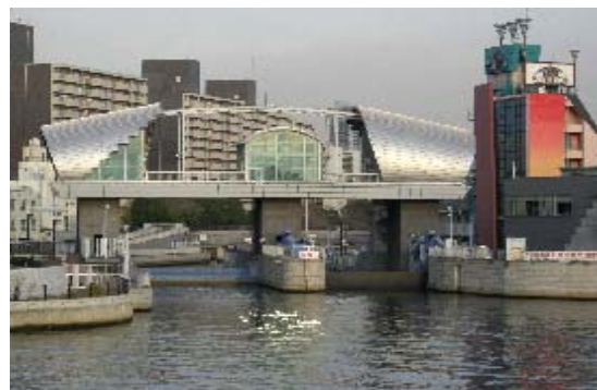
道頓堀川水門
