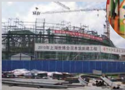
骨組み工事中の日本館
